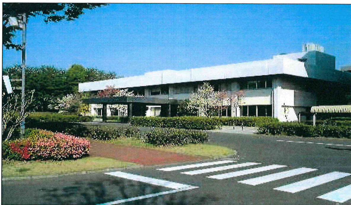
圖八、日本國立障礙者復健中心研究所園區外觀
